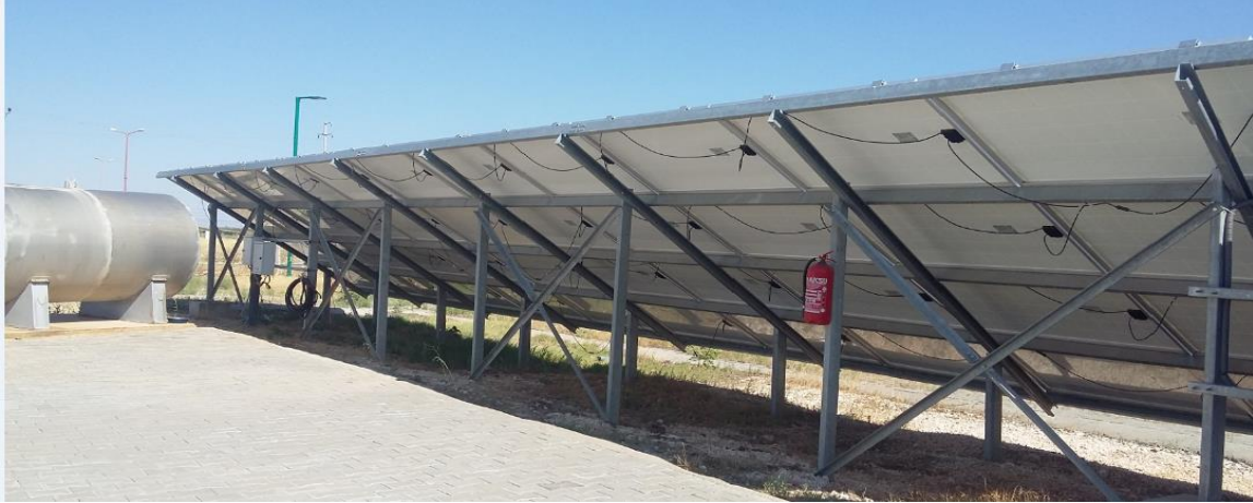
Resim 5.4. Panellerin konstrüksiyonlarla desteklenmesi
