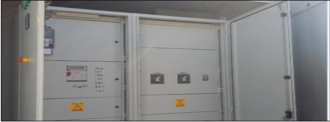
Resim 5.6. Pano kabinini iç kısmı (1)
