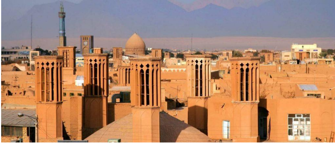
Resim 2.11. yapılarda pasif soğutma sistemi rüzgâr bacası kullanımı
