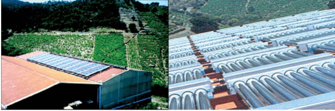
Resim 2.15. Güneş kolektörleri, Fransa şarap evi
