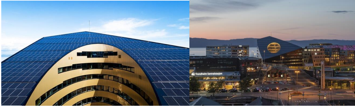
Resim 2.17. Powerhouse Brattørkaia ofisi / Norveç
