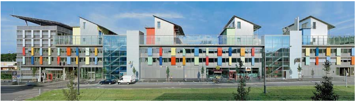
Resim 3.14. Schlierberg ‘de güneş sitesi ticari cepheden görünüm
