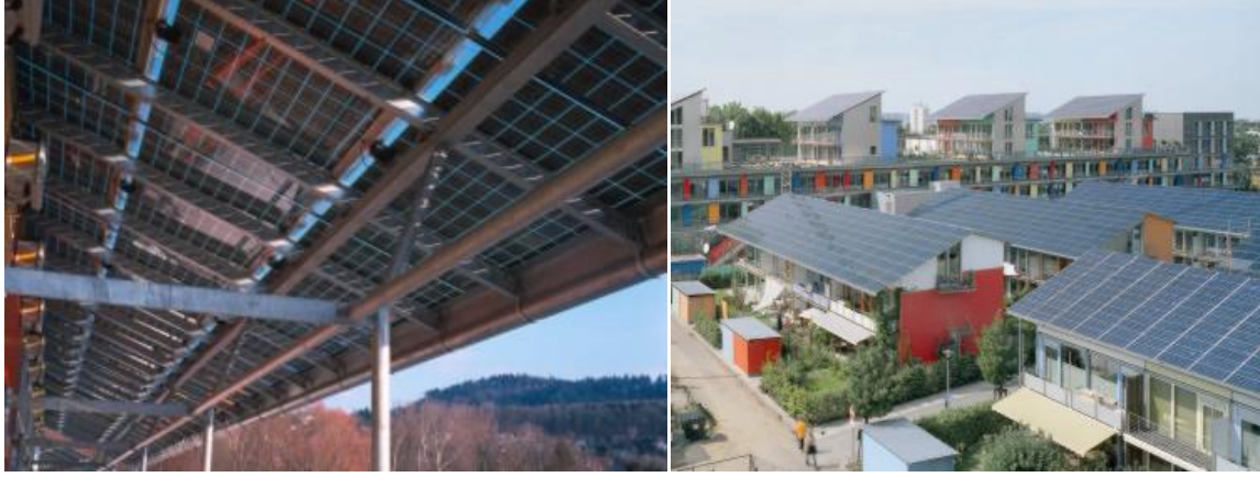
Resim 3.16. Schlierberg 'de güneş sitesi saçak ve pv panel görünümü
