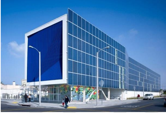
Resim 4.4. 650 adet fotovoltaik panel ile kaplanmış Los Angeles Lisesi
