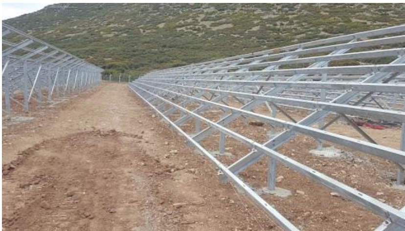
Resim 4.5. Sabit tip FV panel konstrüksiyonu
