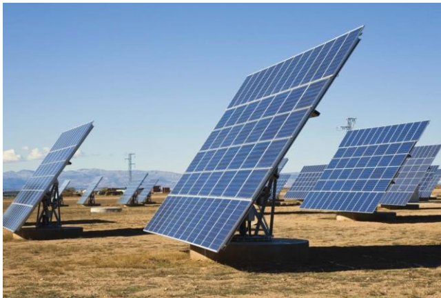
Resim 4.7. Çift eksen kontrollü FV panel konstrüksiyonu
