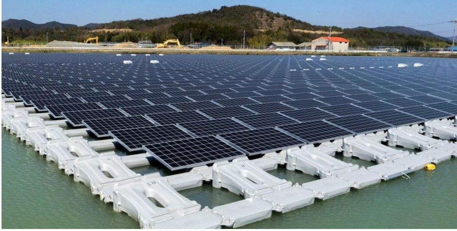
Resim 4.11. HDPE duba üzerine monte edilen panel sistemi örnek görüntüsü
