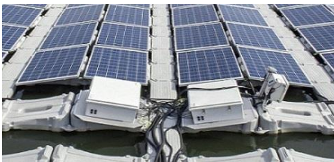
Resim 4.13. Yüzer FV tesisinde kullanılan dizi evirici görüntüsü
