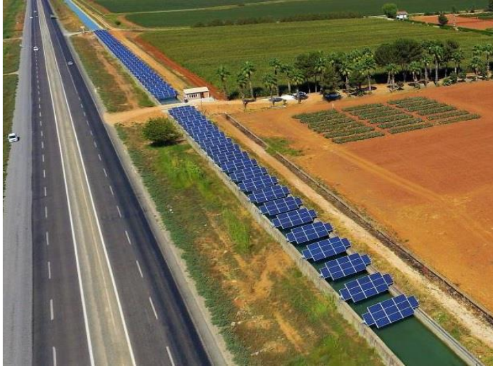
Resim 4.9. Şanlıurfa’da kurulan 160 kWp kurulu gücünde kanal üstü FV tesis görüntüsü
