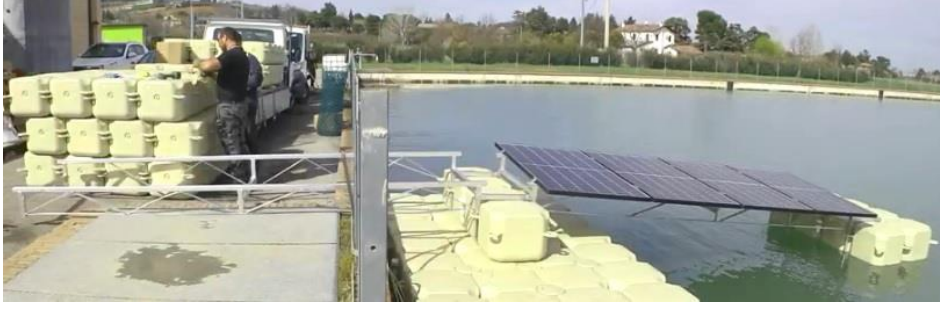
Şekil 5.20. Taşıyıcı duba sistemine irtibatlanan metal profillerle oluşturulmuş iskelet yapısından örnek görüntü.
