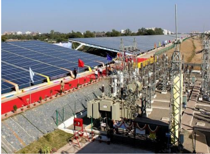
Resim 4.8. Hindistan'daki 10 MW kurulu gücünde kanal üstü FV tesis görüntüsü
