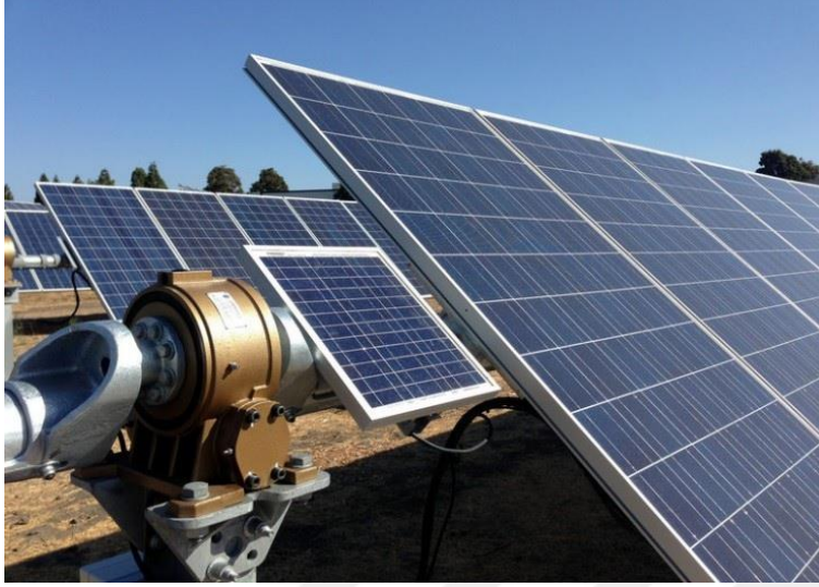
Resim 4.6. Tek eksen kontrollü FV panel konstrüksiyonu
