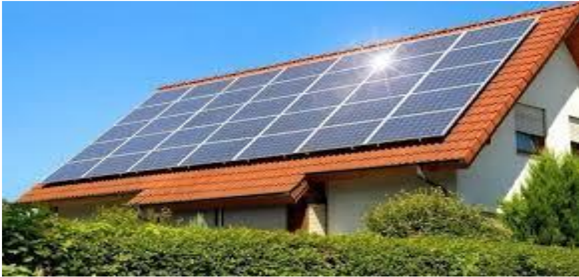
Şekil 2. 2. Güneş enerji sisteminin çatı örtüsü olarak kullanılması
