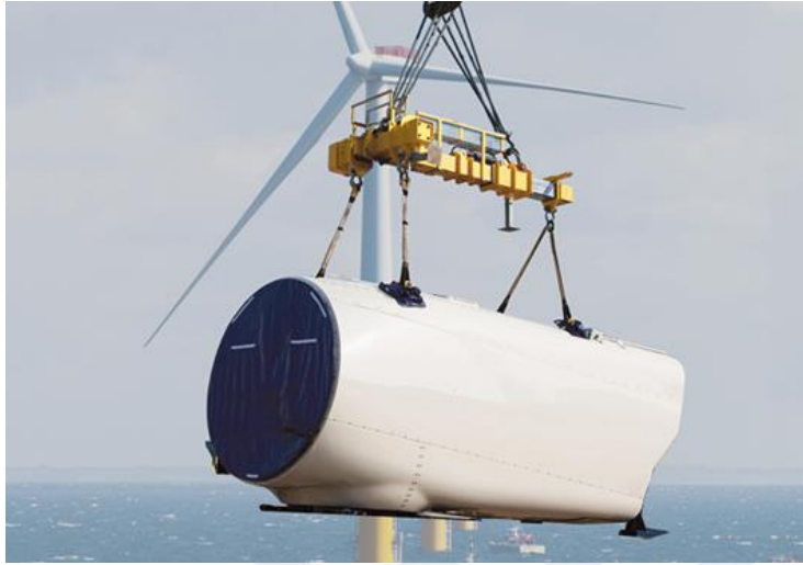
Şekil 2.32 Nasel (Türbin kafa kısmı) [57]
