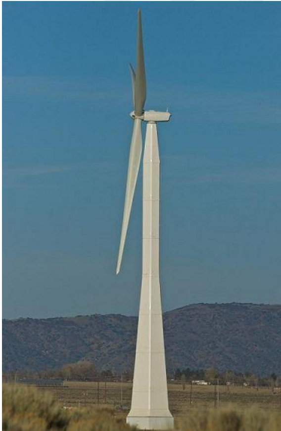
Şekil 2.31 Rüzgar türbini kulesi [57]
