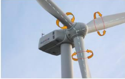
Şekil 2.36 Rüzgar türbini pitch kontrol sistemi
